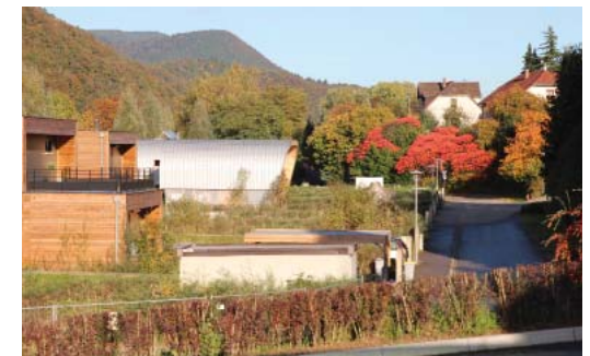
Un lotissement innovant mais bien intégré dans son environnement constructif et paysager, respectueux du cadre de vie
