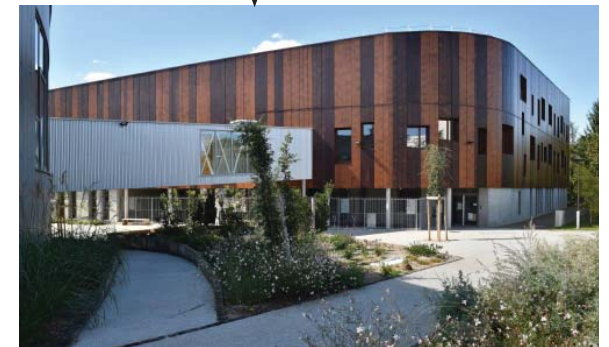
Groupe scolaire Nelson Mandela et antenne de la maison des arts livrés à la rentrée 2015 (Source : ville de Saint-Herblain)
